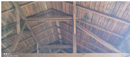
Więźba dachowa z deskowaniem
